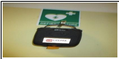
CORRIDOIO PIANO SEMINTERRATO DIREZIONE PALESTRA
